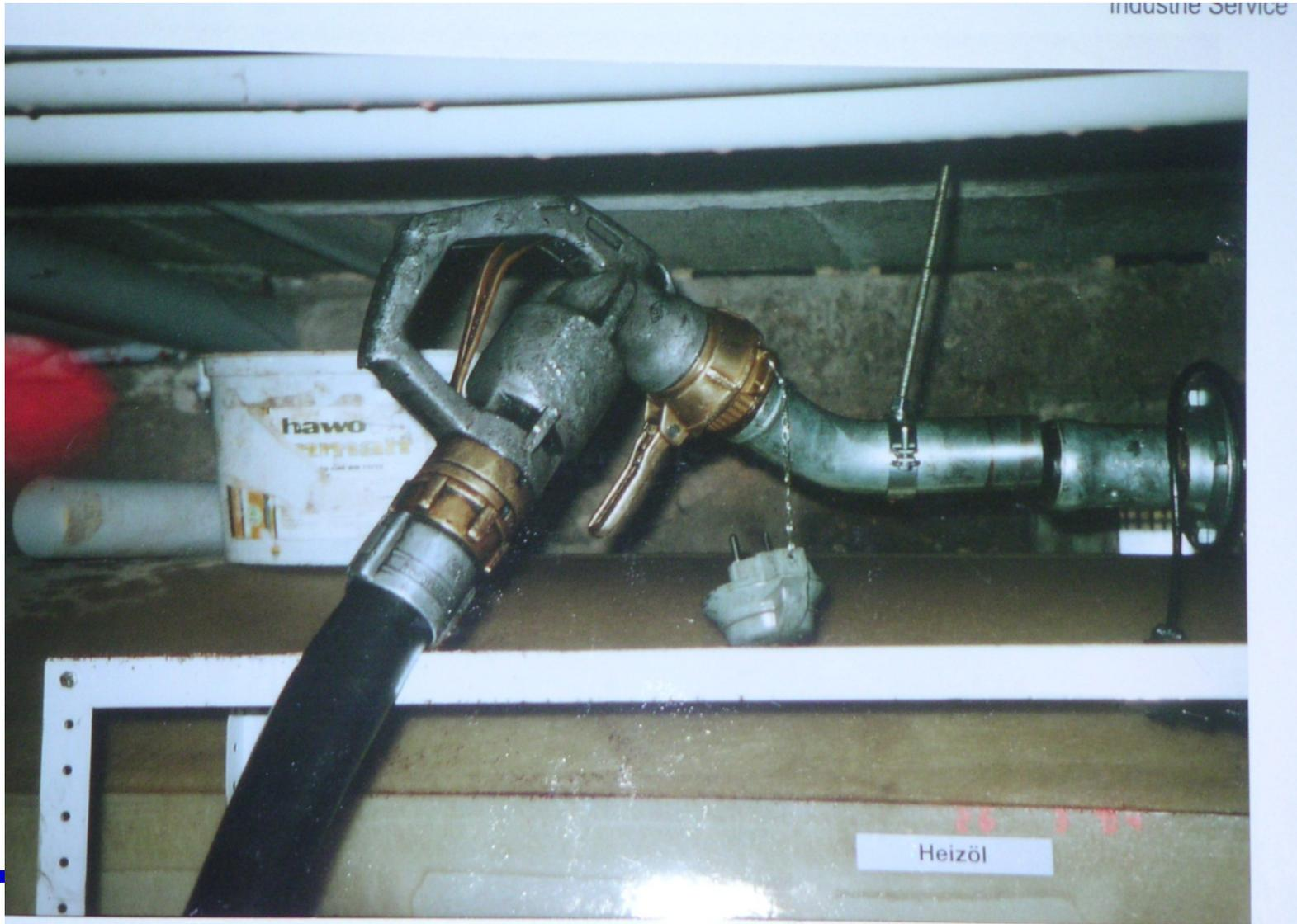
...schlussarmatur des Füllschlauchs (mit Haltegriff) montiert am Füllstutzen des Tanker...
