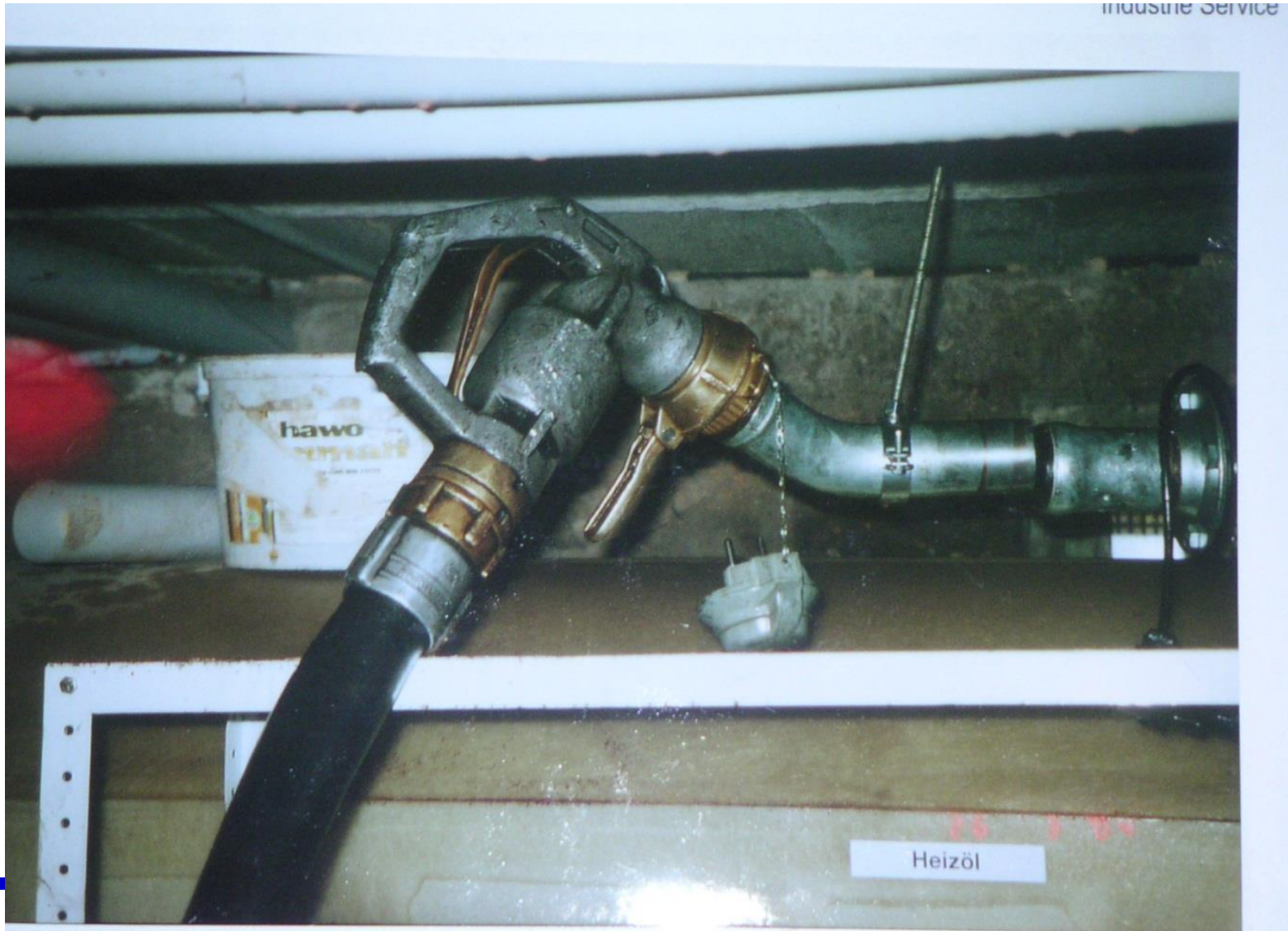
...schlussarmatur des Füllschlauchs (mit Haltegriff) montiert am Füllstutzen des Tankes
